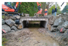
Remplacement de 2 passages à gué busés par des PIPO à Ussel-d'Allier
