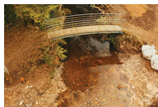
Restauration de la berge et aménagement d'un passage à gué sur le petit Sioulet à Sauvagnat
