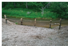
Restauration des berges de la Bouble à Bayet - Nérignet (Caisson, peignes, fascine et abreuvoir)
